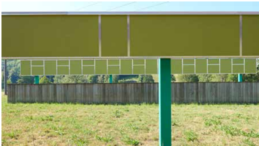
Abb. 62: Betontiefblende und 2 Hochblenden Nahblendenkonstruktion
