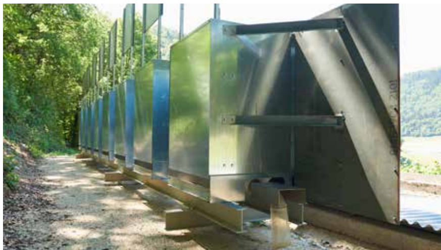
Abb. 50: Kugelfangsystem Seitenansicht Berin
