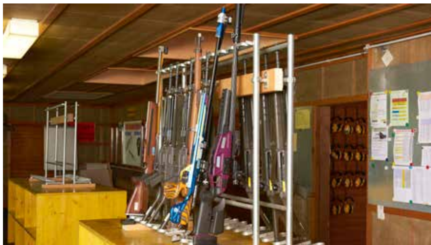
Abb. 28: Gewehrrechen nicht an Wand montiert
