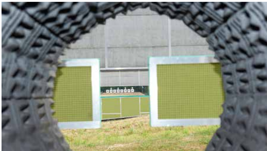
Abb. 63: Seitenblende Nahblendenkonstruktion mit Tunnel (Sicht des Schützen)
