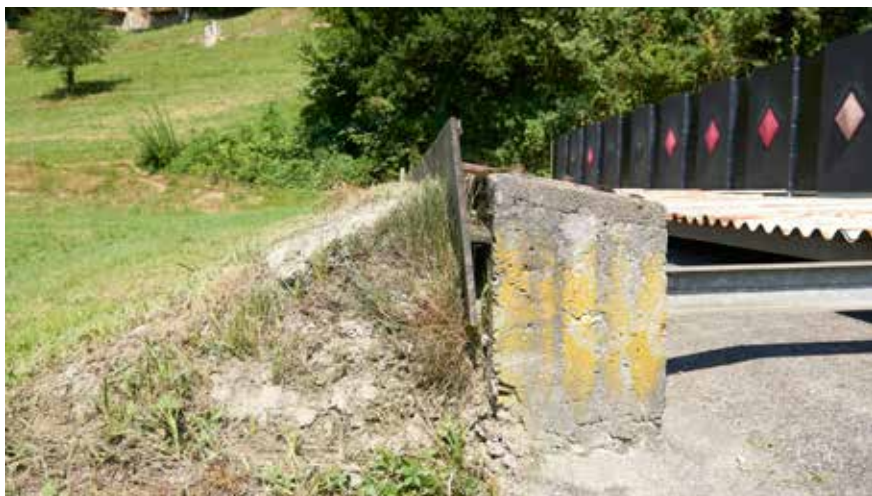
Abb. 38: Ansicht der montierten Prellplatte
