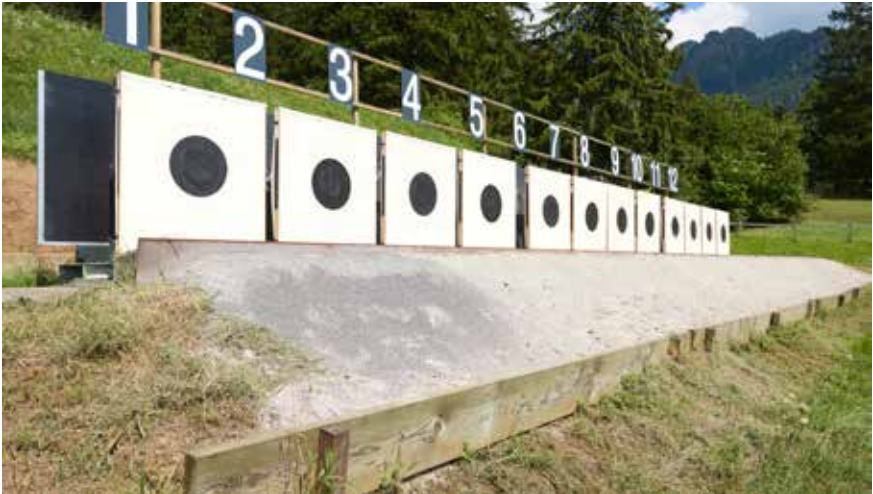
Abb. 40: Vorkugelfang Sand mit montierter Prellplatte
