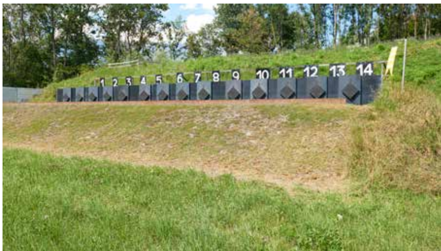
Abb. 39: Vorkugelfang Erde mit montierter Prellplatte
