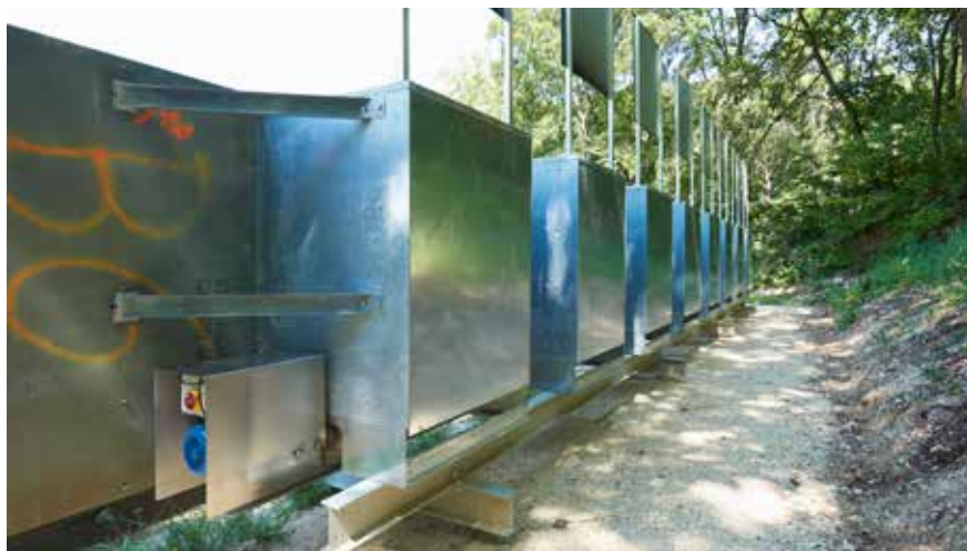
Abb. 53: Kugelfangsystem von hinten Berin mit Austragungssystem
