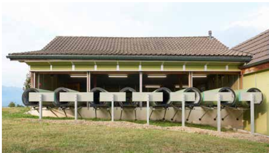
Abb. 64: Seitenblende Nahblendenkonstruktion mit Tunnel (Sicht von aussen)
