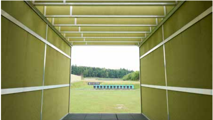
Abb. 20: Schallschutzwand mit Fächer oben
